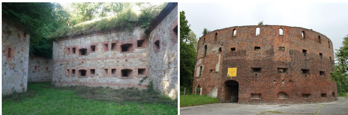
Zdj. 14 Nysa. Jeden z obiektów twierdzy - Fort II Regulicki, fot. I. Solisz; Zdj. 15 Kędzierzyn – Koźle. Fort Fryderyka Wilhelma, tzw. Baszta Montalemberta, fot. Grzegorz Naumowicz
